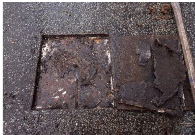
foto /8/ Pohled do provedené sondy po odstranění 1. hydroizolační vrstvy
