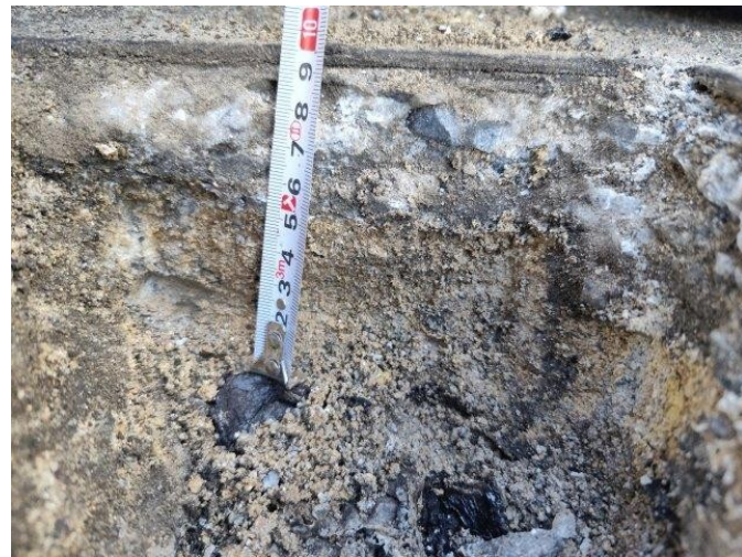
foto /10/ Pohled na odměřování vrstev betonu a křemičitého písku, tl. 90 mm
