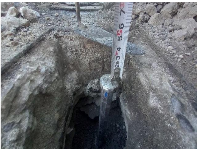
foto /11/ Pohled na odměřování celkové hloubky sondy, tl. cca 420 mm
