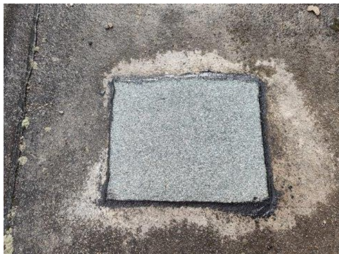
foto /19/ Pohled na zapravenou sondu S2 obdobnou hydroizolací
