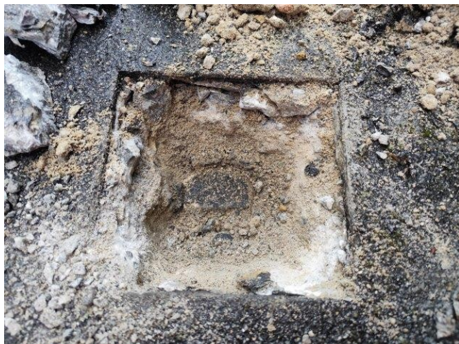
foto /16/ Pohled do provedené sondy po odstranění vrstvy z křemičitého písku
