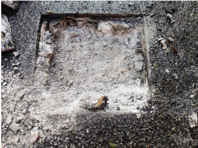
foto /15/ Pohled do provedené sondy po odstranění betonové vrstvy
