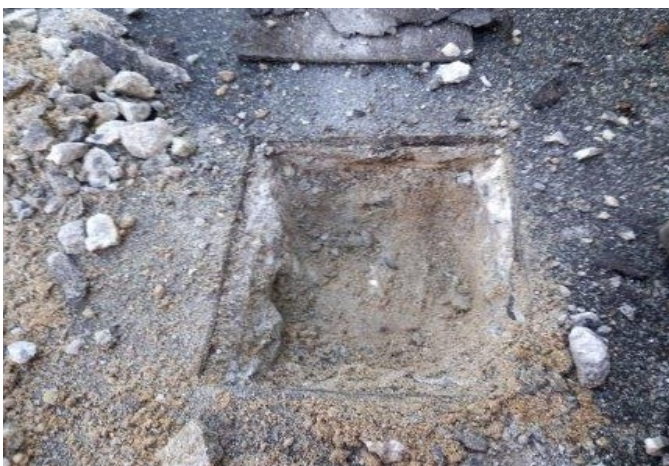
foto /9/ Pohled do provedené sondy po odstranění betonové vrstvy
