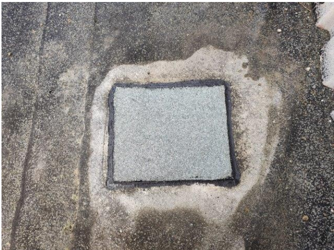
foto /13/ Pohled na zapravenou sondu S1 obdobnou hydroizolací
