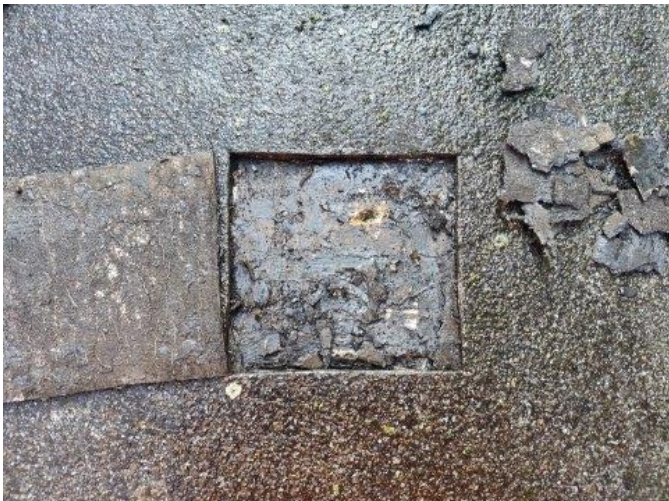
foto /14/ Pohled na provedenou sondu po odstranění souvrství asfaltových pásů
