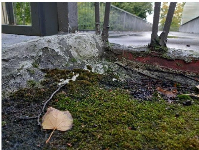
foto /4/ Pohled na kotvení zábradlí a zatmelení dodatečnou hydroizolační stěrkou
